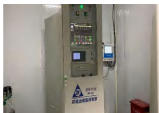
焙烧烟气在线监测装置
